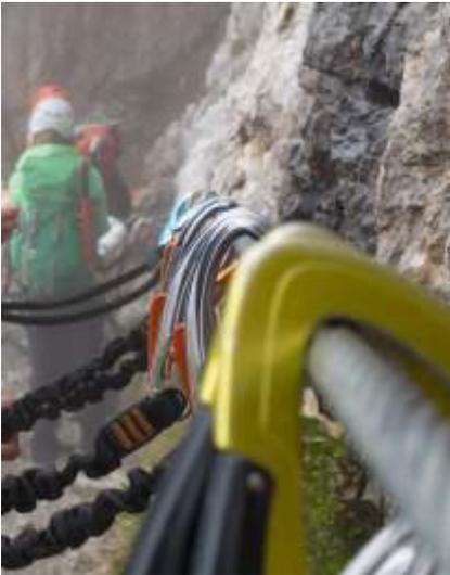
Ein Klettersteig ist ein mit Eisenleitern, Eisenstiften, Klammern (als Trittstufen) und (Stahl-)Seilen gesicherter (versicherter) Kletterweg am natürlichen oder künstlichen Fels. Früher wurden Felspassagen von Wanderwegen mit Stahlseilen abgesichert. Daraus entwickelten sich mit der Zeit Klettersteige, die immer schwierigere Routen für Nicht-Kletterer begehbar machten. Heute hat sich das Begehen von Klettersteigen zu einer eigenen alpinen Disziplin weiterentwickelt.
